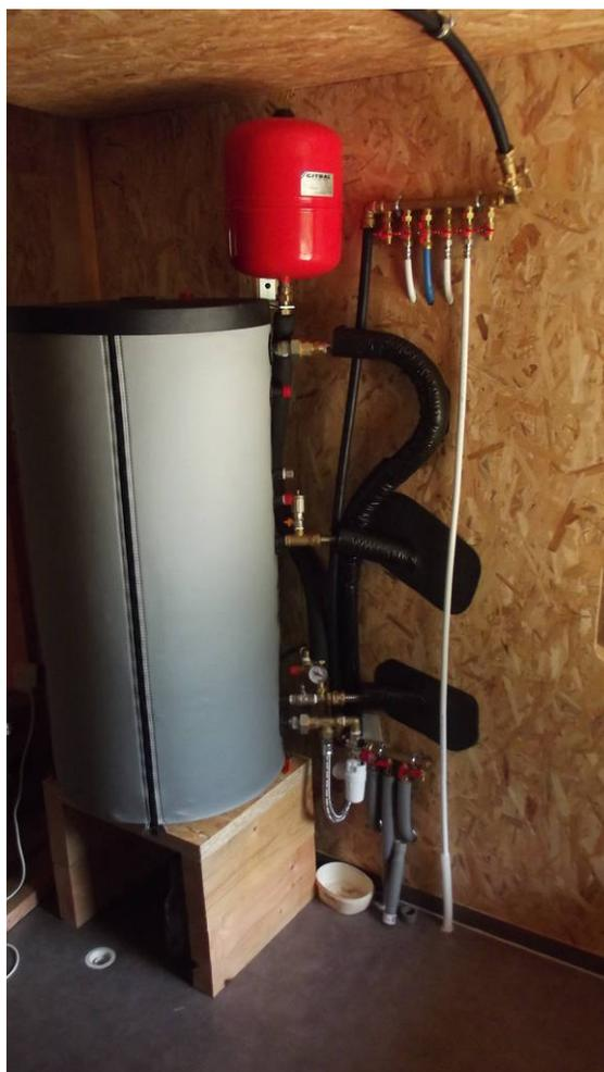
Sur la photo, il manque encore la connexion du siphon du groupe sécurité ballon au réseau d'évacuation des eaux usées (d'où le tupperware au sol). Il faudrait aussi peaufiner l'isolation des conduits et raccords du circuit chaud. Mais j'attends encore un peu, ça me rassure de pouvoir passer la main sur les raccords et ne pas sentir d'humidité...
